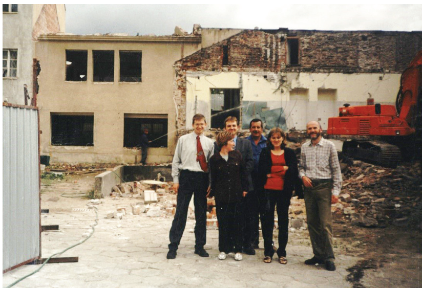
29. Pracownicy BUKSW na tle dawnej wypożyczalni. Budynki wyburzane w miejscu, w którym powstanie tzw. Łącznik, 2001 r.
