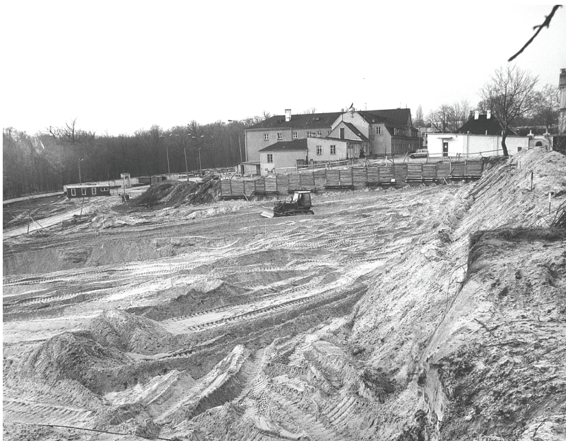
1. Przygotowanie miejsca pod budowę nowego gmachu ATK, rok 1994. Ze zbiorów Biblioteki UKSW
