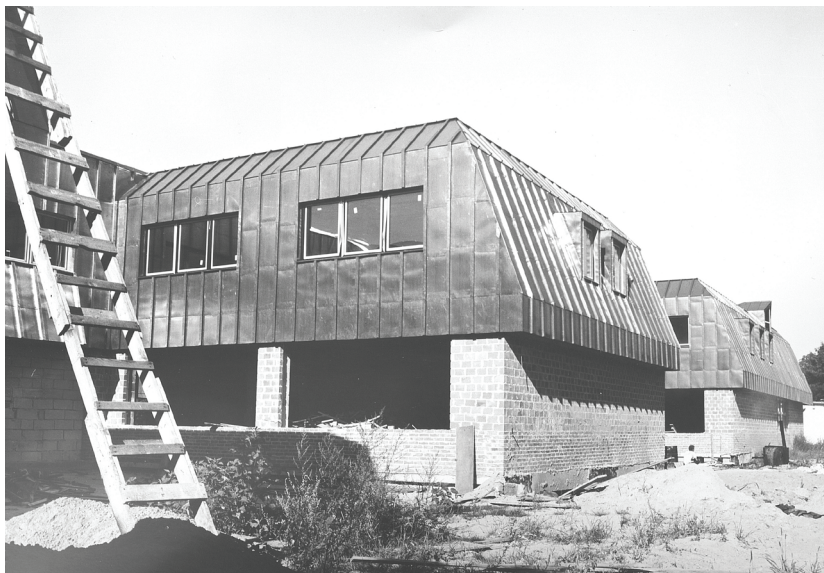
2. Budowa nowego gmachu ATK, rok 1997. Ze zbiorów Biblioteki UKSW
